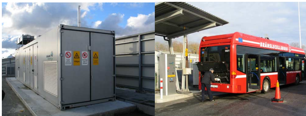
Figur 2 Kombinert hydrogenproduksjon (til venstre) og fyllestasjon (til høyre) i Stockholm
