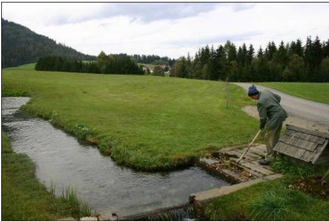
**Bilde 17** Bonden reinskar inntaket til kraftverket for lauv
