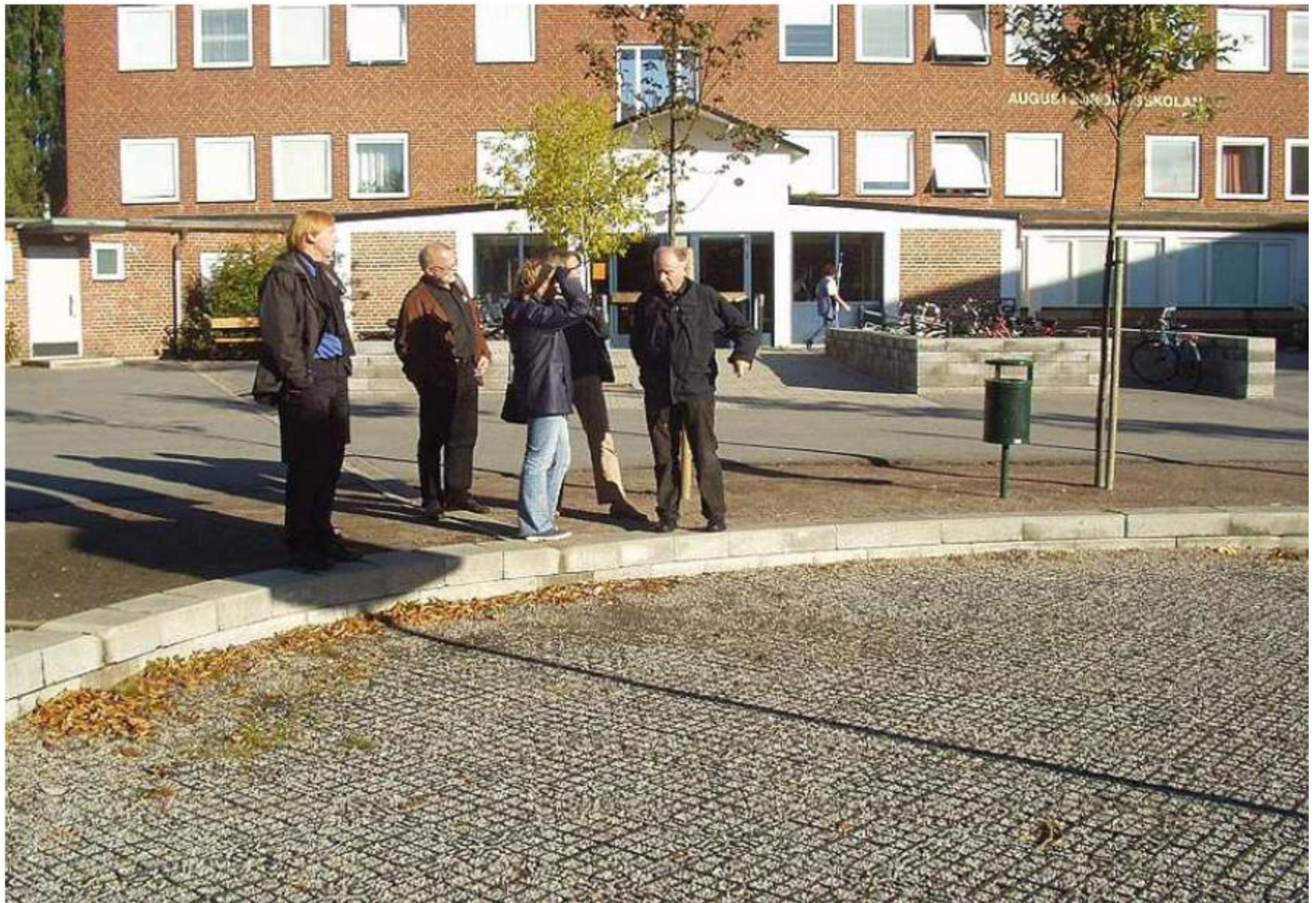
Lekeplass som fordrøynings-og infiltrasjonsbasseng (Malmø)
