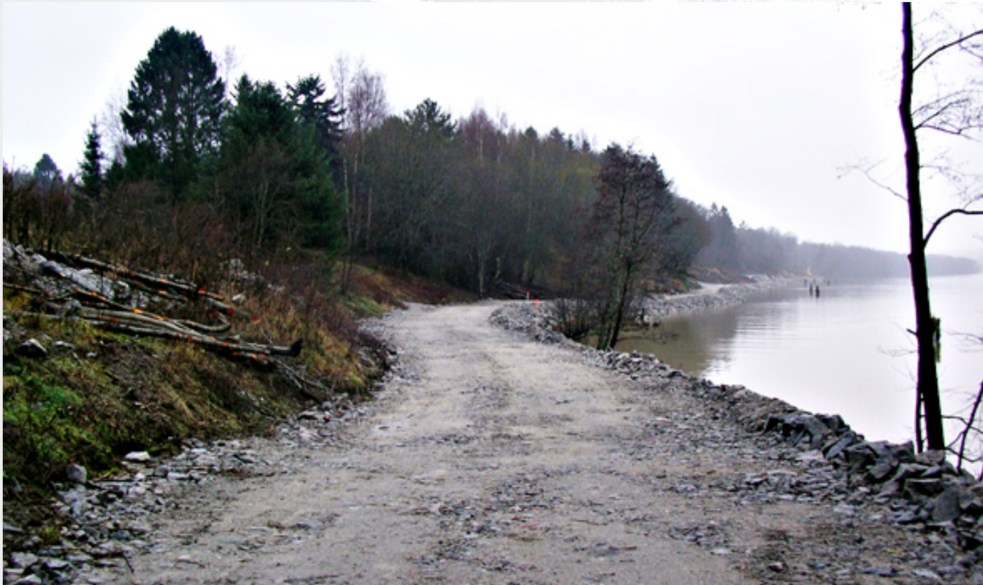
Motfylling for å stanse erosjonen i en elv på Moum, Fredrikstad (kilde:NGI)
