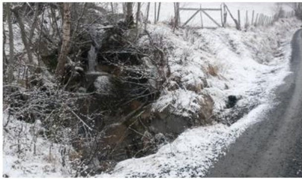
Eksempel på dårlig konstruert bekkeinntak, gjenfylt jordbruksavkjørsel med underdimensjonert drensør
