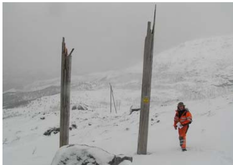
Fleire master vart knekte tvers av i uvêret (Foto: Nord-Salten Kraftlag).
