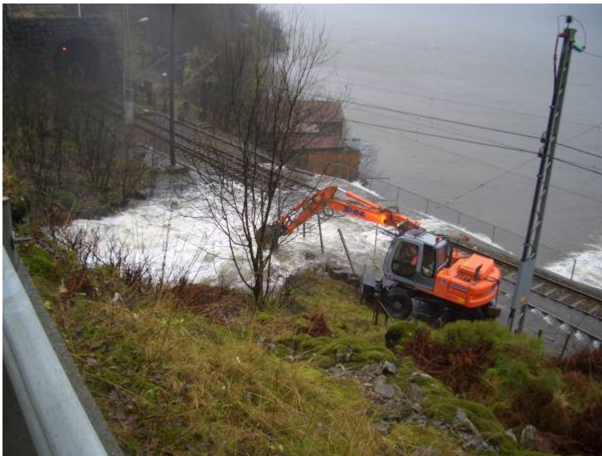
Elva Kråksåna undergrov jarnbaneskinnene sør for Stanghelle stasjon i Vaksdal (Foto: Per Nordmark).
