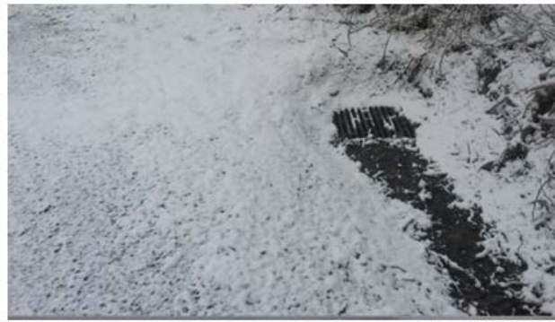
Eksempel på sårbar rist på inntakskum
