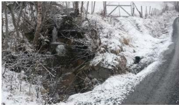
Eksempel på dårlig konstruert bekkeinntak, gjenfylt jordbruksavkjørsel med underdimensjonert drenerør
