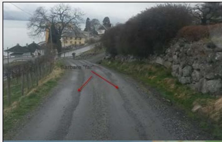
Eksempel på dårlig konstruert bekkeinntak, gjenfylt jordbruksavkjørsel med underdimensjonert drenerør
