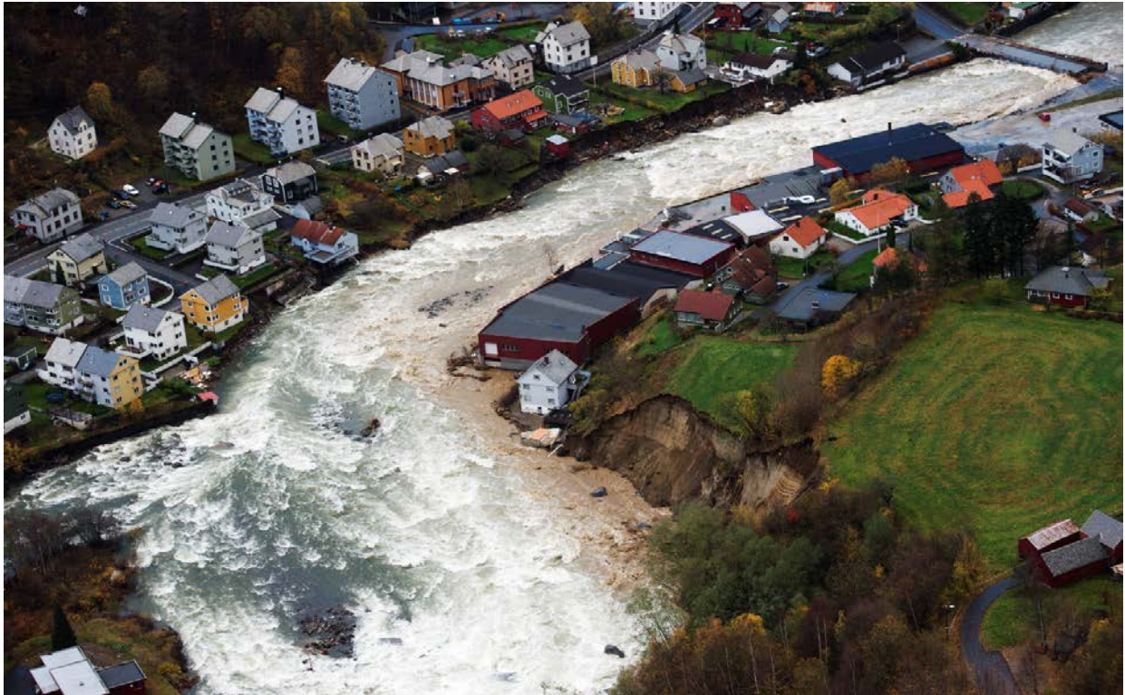
Figur 1 Elva Opo gjorde store skadar i Odda under oktoberflaumen i 2014. Foto: Marit Hommedal/NTB Scanpix.
