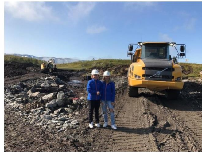
Anna Bryn(t.v.) og Synva Vinje i Voss Resort under byggingen av det nye høydebassenget. Foto: Voss Resort
