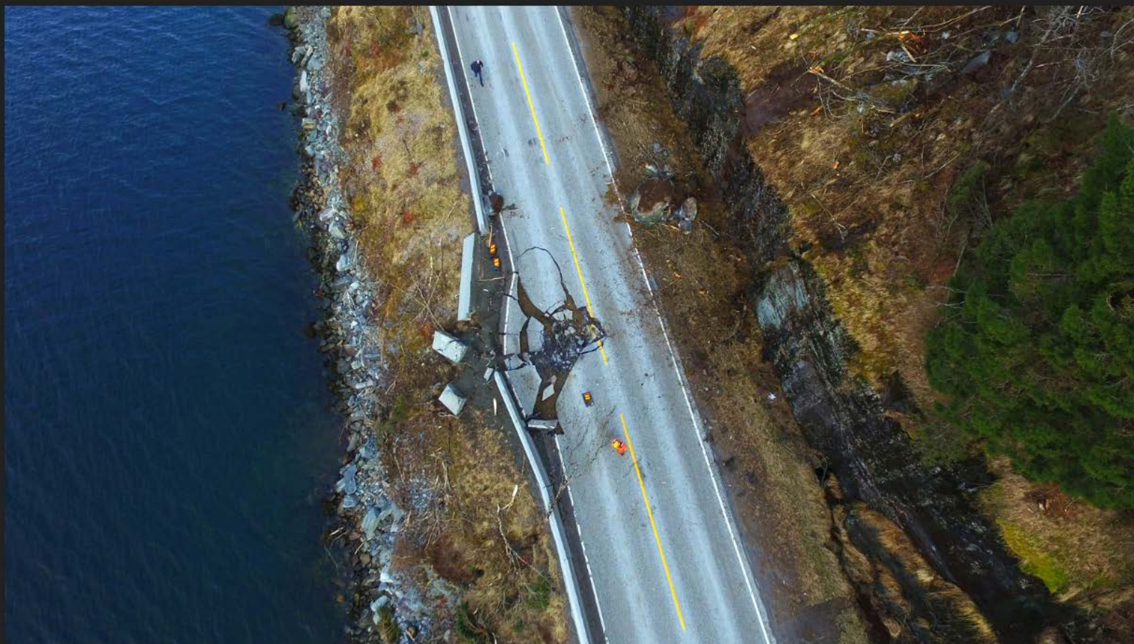
Ras på riksveg fem mellom Førde og Naustdal FOTO: ALF VIDAR SNÆLAND
